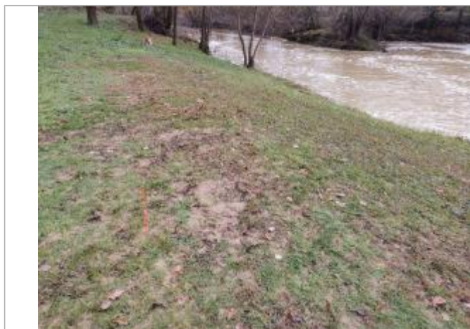
Vue du repère - Photo ©AGERIN
