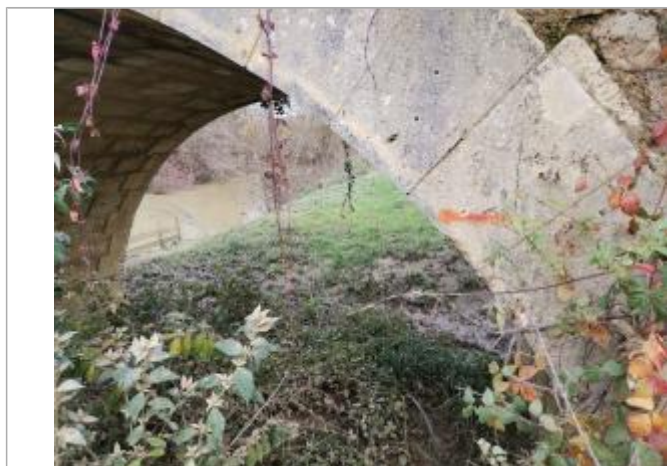
Vue du repère - Photo ©AGERIN
