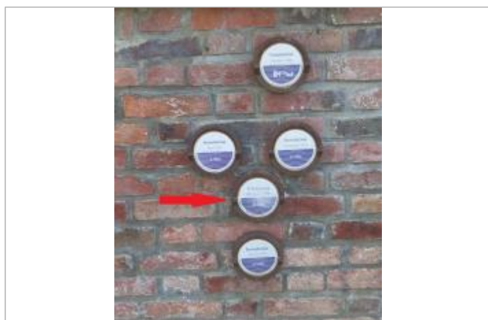
Repère normalisé de l'inondation du 29 décembre 1999
