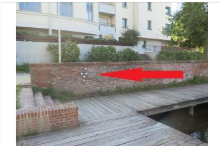
muret de brique
