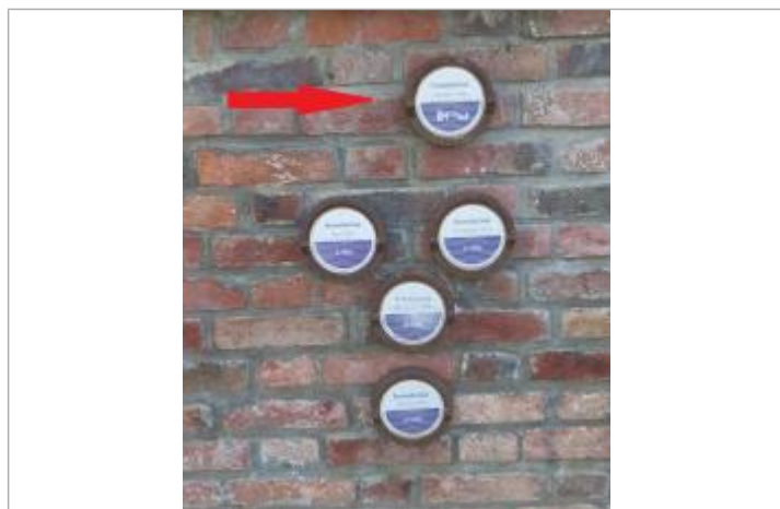
Repère normalisé de l'inondation du 24 octobre 1966
