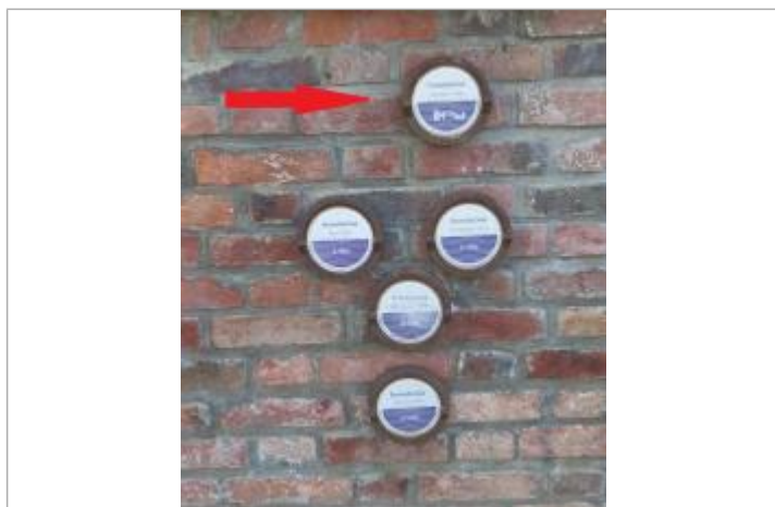
Repère normalisé de l'inondation du 24 octobre 1966
