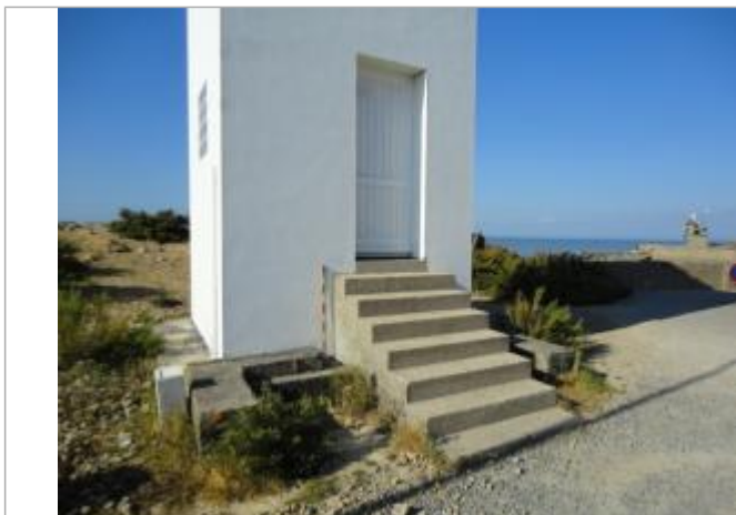
Muret béton du phare
