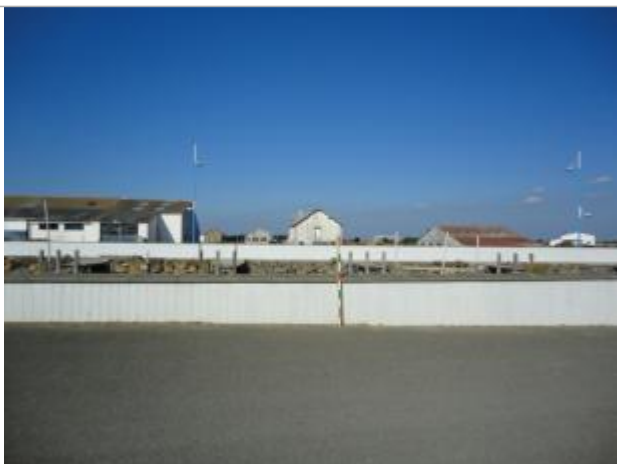
Repère placé à proximité du phare
