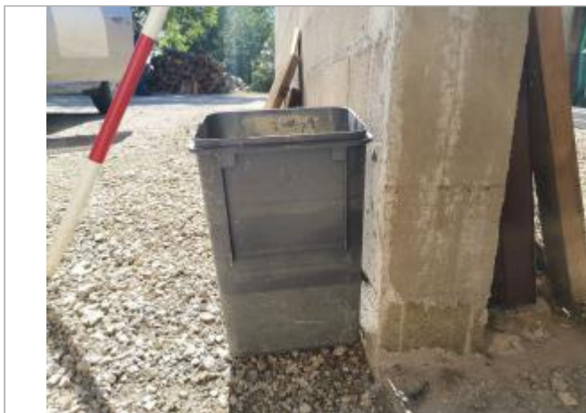
Mur bâtiment - Photo © AGERIN
