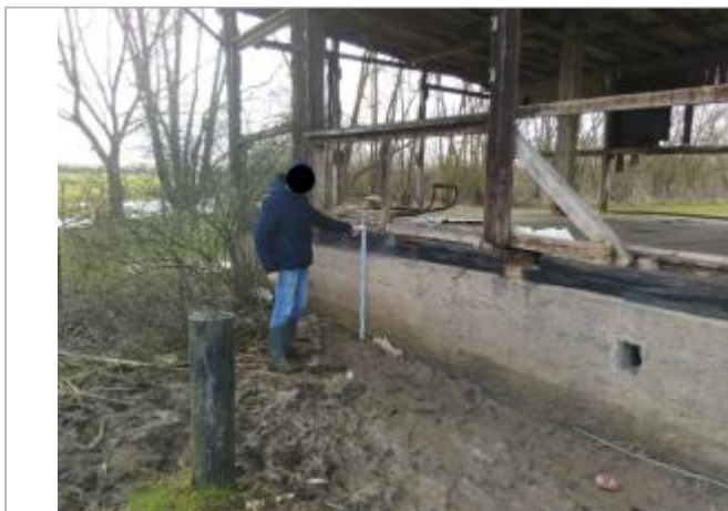
Vue du site
