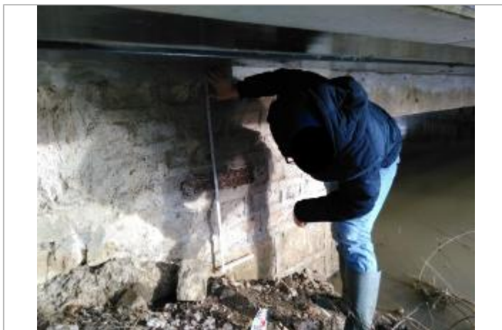
Vue du site
