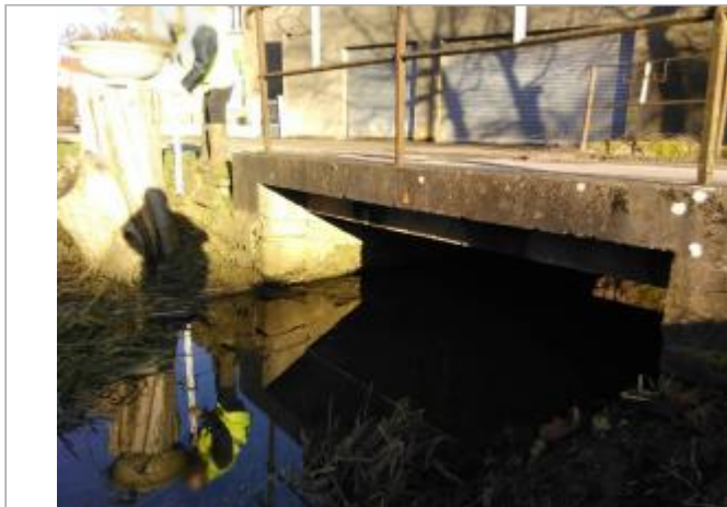
Vue du site
