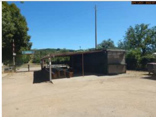
Vue du site éloignée
