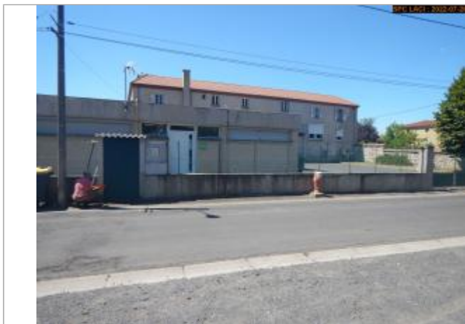
Vue du site éloignée
