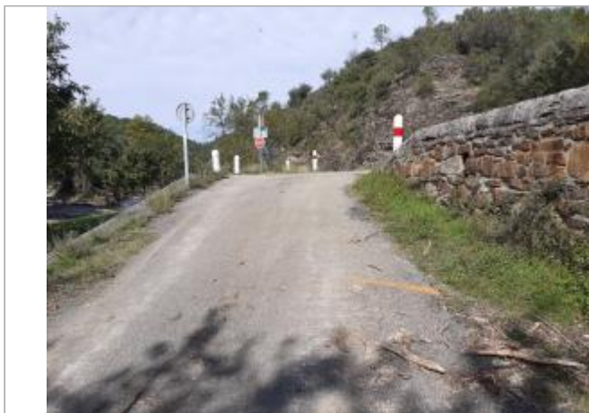
Vue du site
