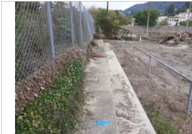
Vue du site
