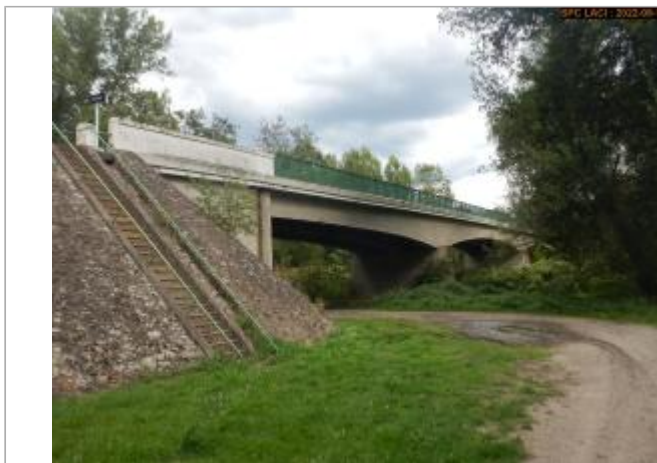
Vue du site éloignée
