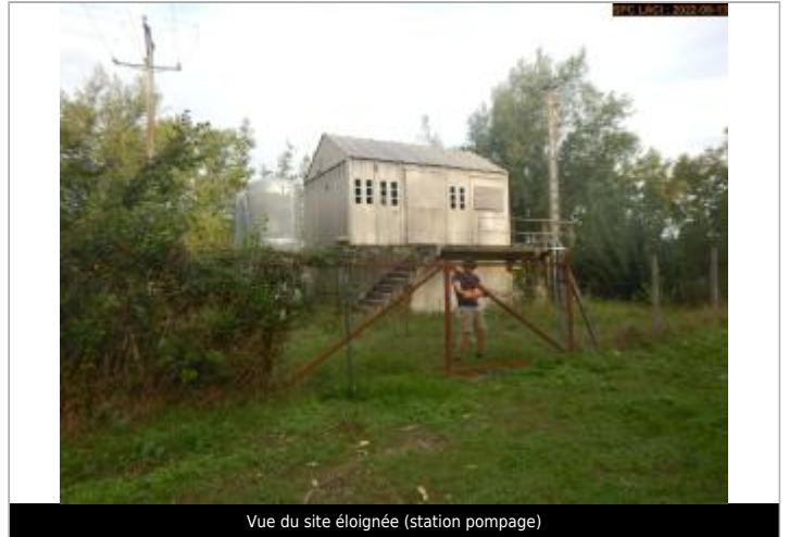
Vue du site éloignée (station pompage)
