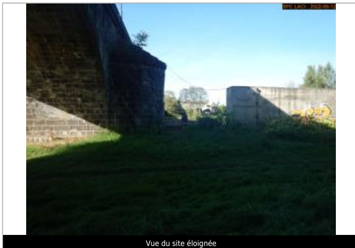
Vue du site éloignée
