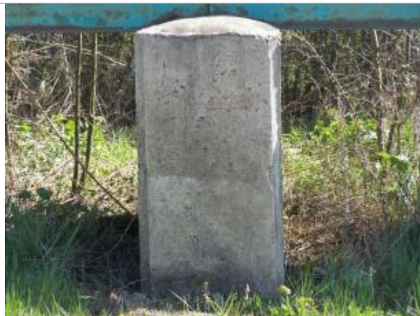
pile n° 5 de la passerelle piétonne
