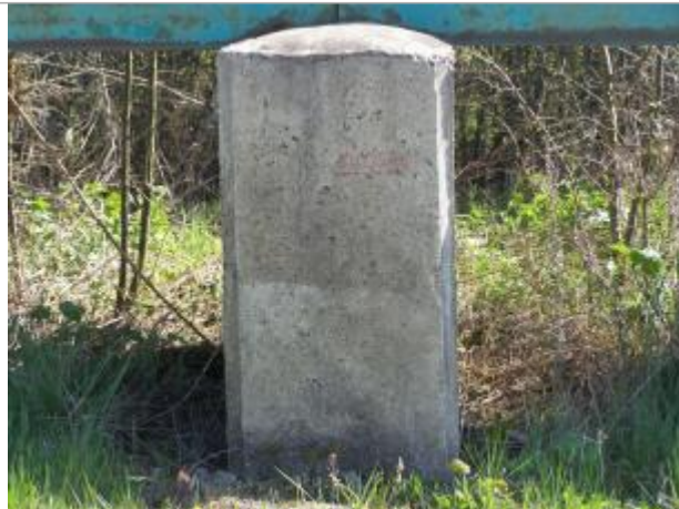
pile n° 5 de la passerelle piétonne
