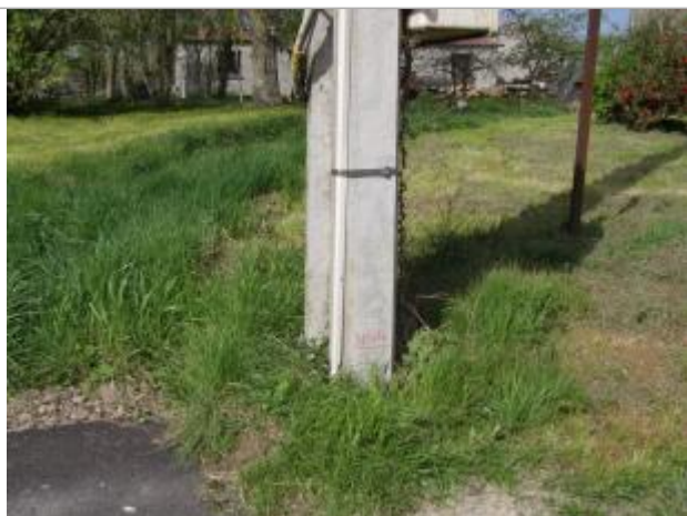
Emplacement du nivellement reporté
