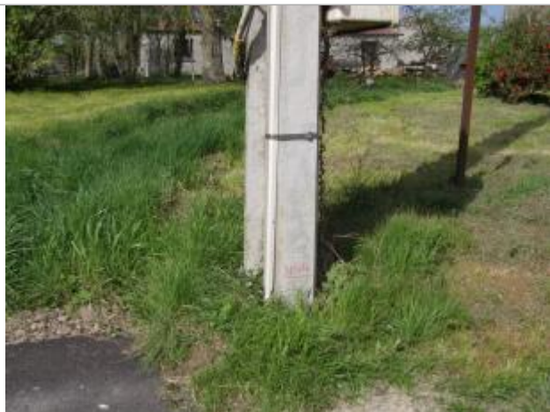
Emplacement du nivellement reporté
