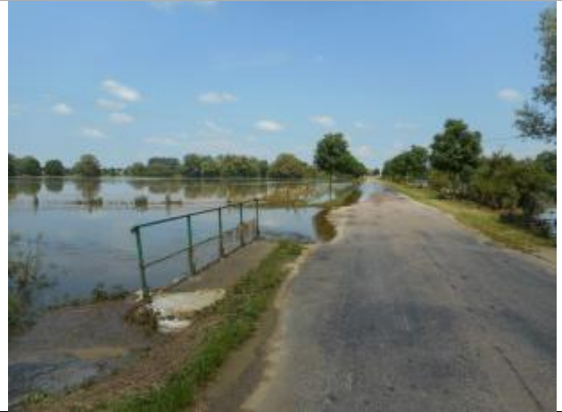
passerelle RD n° 163
