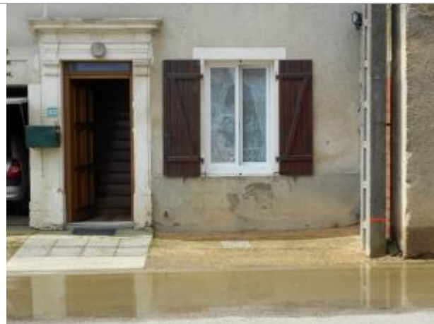
poteau EDF devant le 22 rue du Paquis
