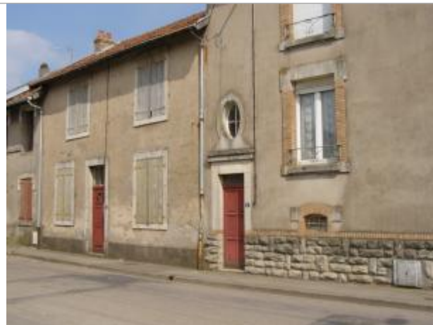
porte d'entrée du 6 rue de Foameix
