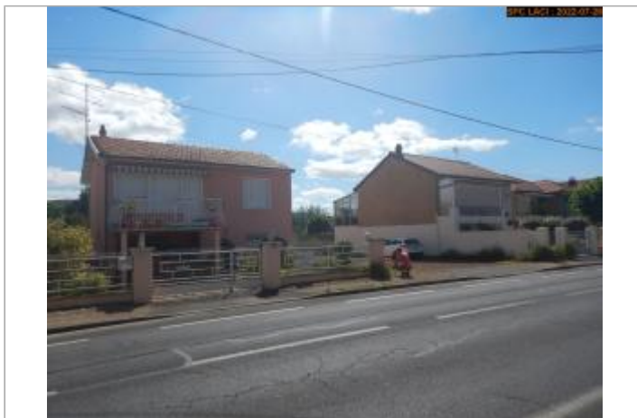
Vue du site éloignée
