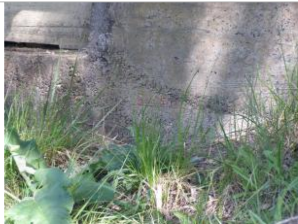
mur en retour culée avale rive gauche
