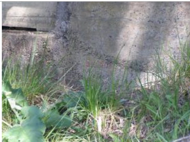
Emplacement du nivellement reporté
