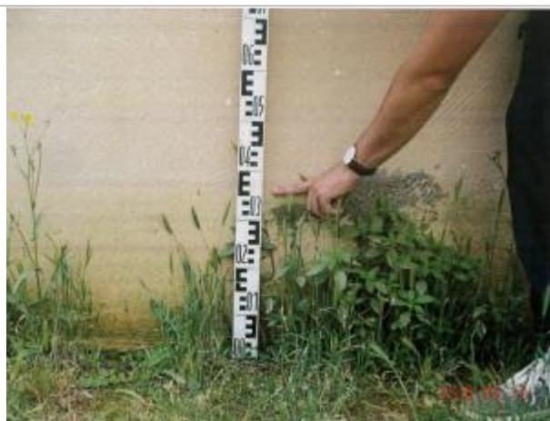
Laisse de crue sur le mur à 35 cm du sol.
