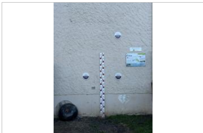
Photo des repères
