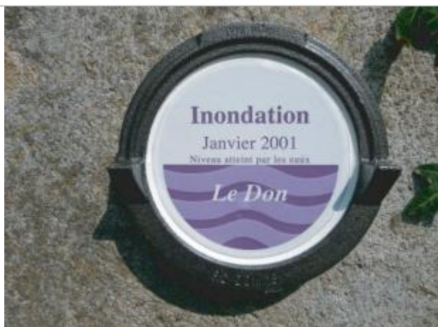
Repère de crue normalisé de janvier 2001
