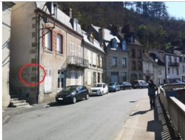
A l'angle du mur du bâtiment au niveau de l'escalier
