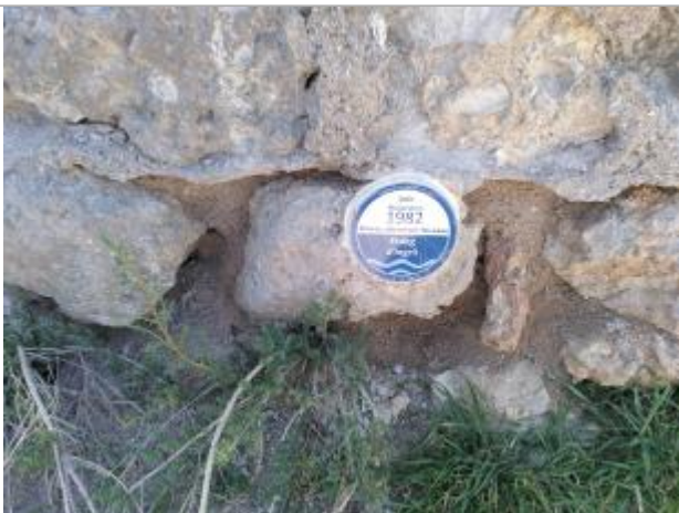
Zoom sur le repère de crues
