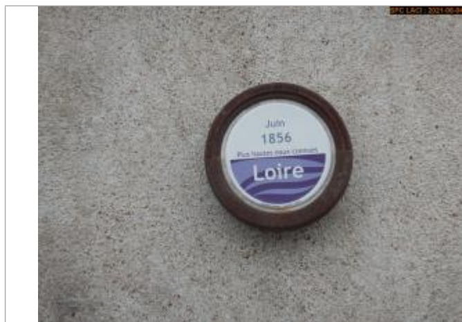
Vue du repère rapprochée en 2021
