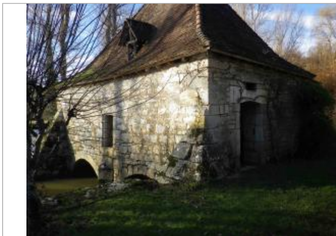
Vue du site - Auteur : GEOSPHAIR
