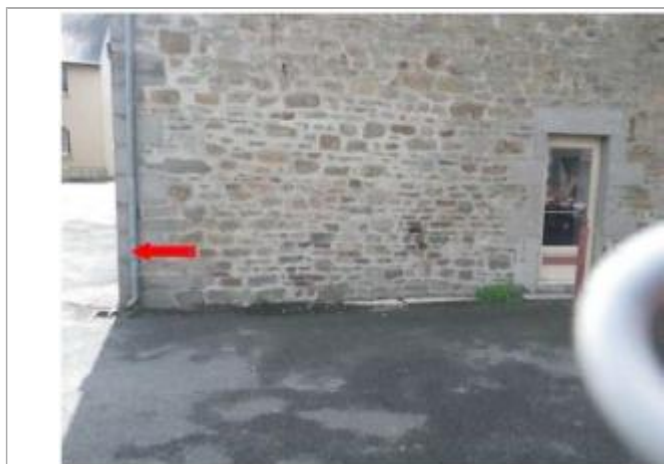
Laisse de crue sur le mur à 10 cm du sol.
