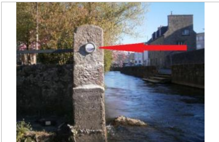
Repère normalisé de l'inondation du 23 janvier 1995
