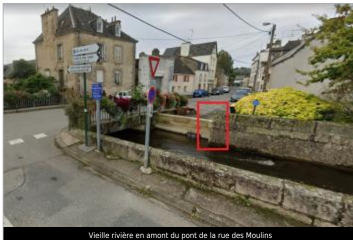
Vieille rivière en amont du pont de la rue des Moulins
