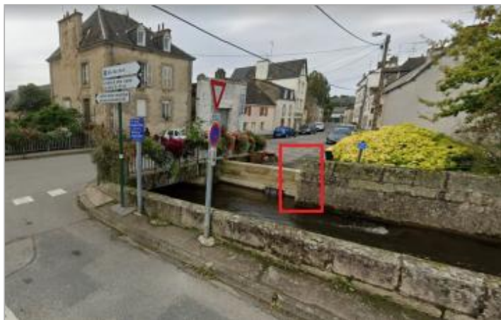
Vieille rivière en amont du pont de la rue des Moulins
