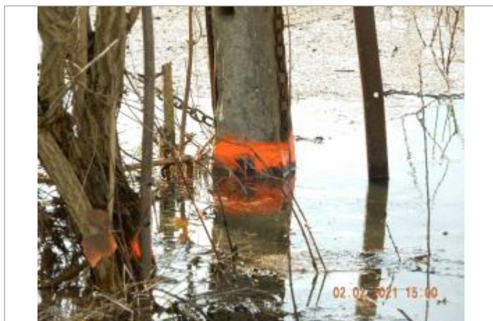
marque de peinture sur poteau en ciment
