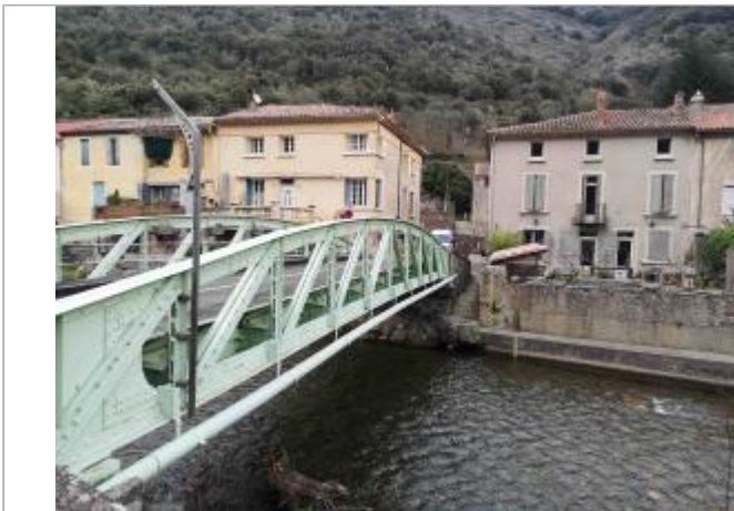
Echelle de crue en amont rive droite du pont de la D601 à Les Ilhes
