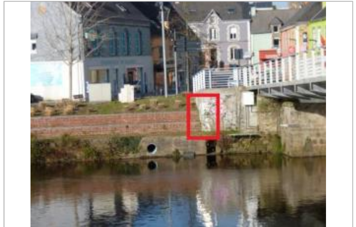
pont de la RD23 entre Inzinzac-Lochrist et Hennebont
