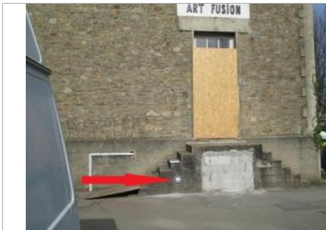
escalier entrée du bâtiment
