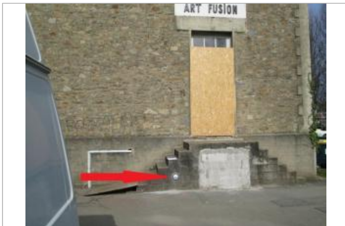
escalier entrée du bâtiment
