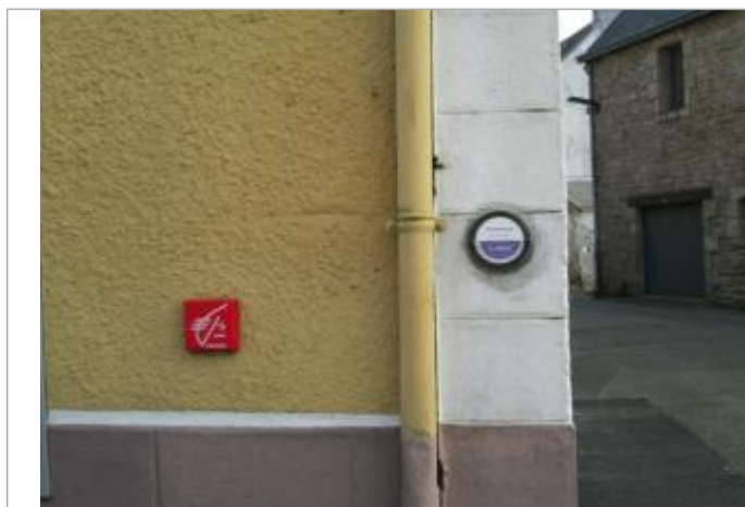
Repère normalisé de l'inondation du 5 janvier 2001
