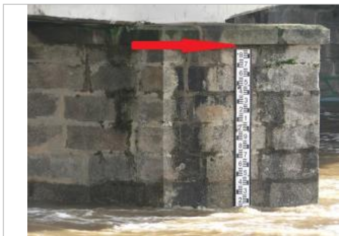
Echelle limnimétrique de la station hydrométrique lors de la crue de janvier 2008
