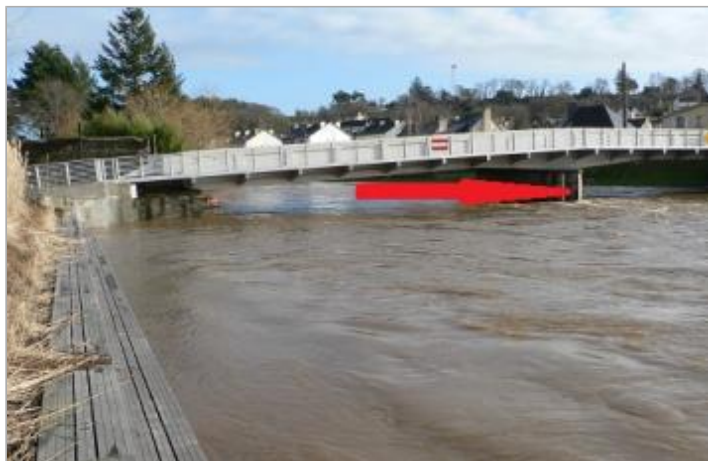
Echelle sous le pont de la RD23 entre Inzizac-Lochrist et Hennebont
