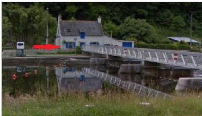
Maison éclusière et grand barrage
