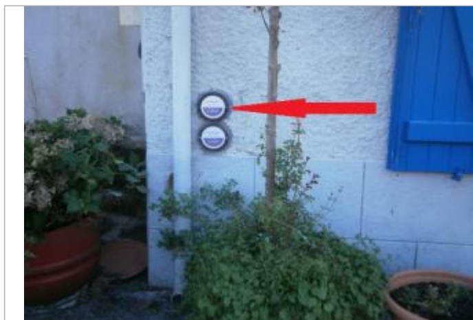
Repère normalisé de l'inondation du 5 janvier 2001
