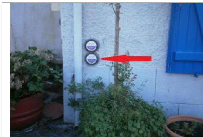
Repère normalisé de l'inondation du 26 janvier 1995
