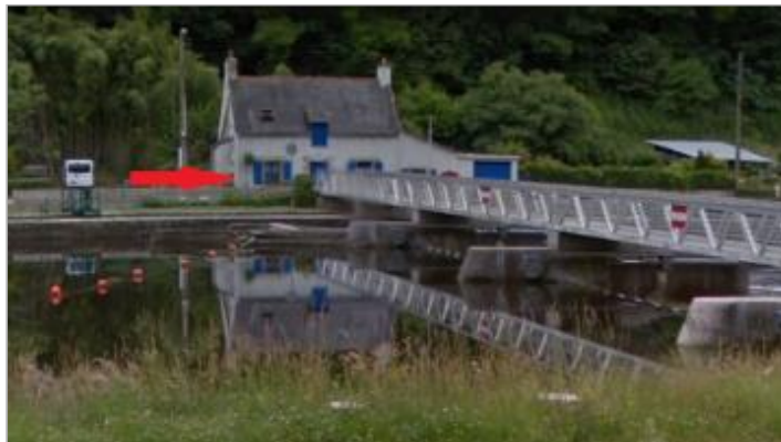
Maison éclusière et grand barrage
