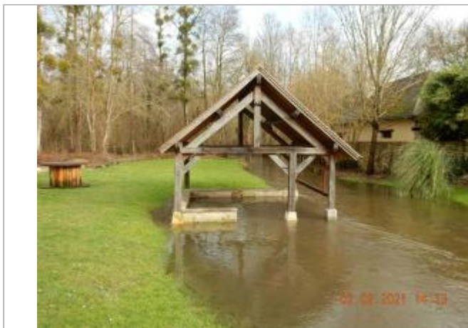
Lavoir rue de l'Eau
