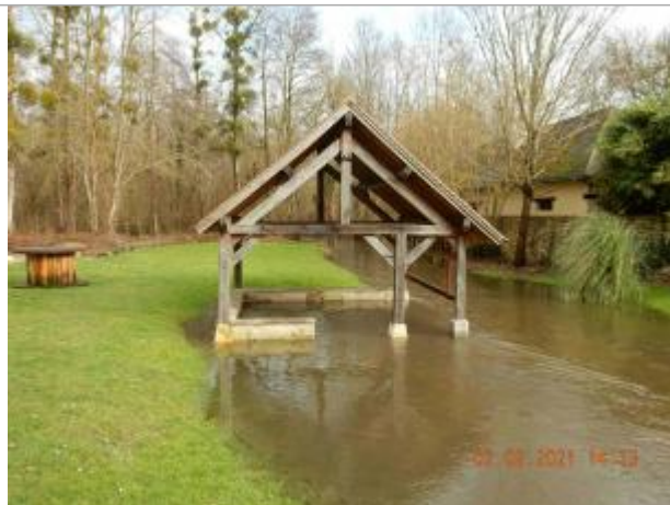
Lavoir rue de l'Eau
