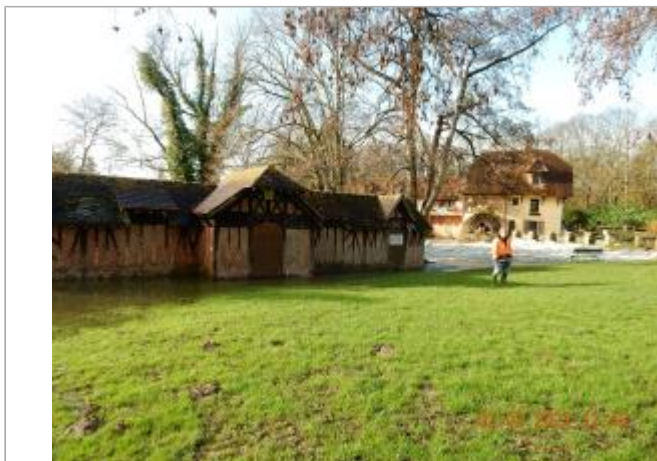
Bâtiment sur la rive gauche, face au moulin de Fourges
