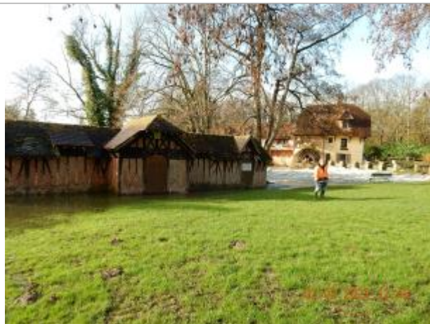
Bâtiment sur la rive gauche, face au moulin de Fourges
